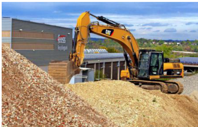
Der Einsatz von Recycling-Baustoffen wird laut Bauwirtschaft Baden-Württemberg in der Hälfte aller Ausschreibungen ausgeschlossen. FOTO: SCHMIDT
